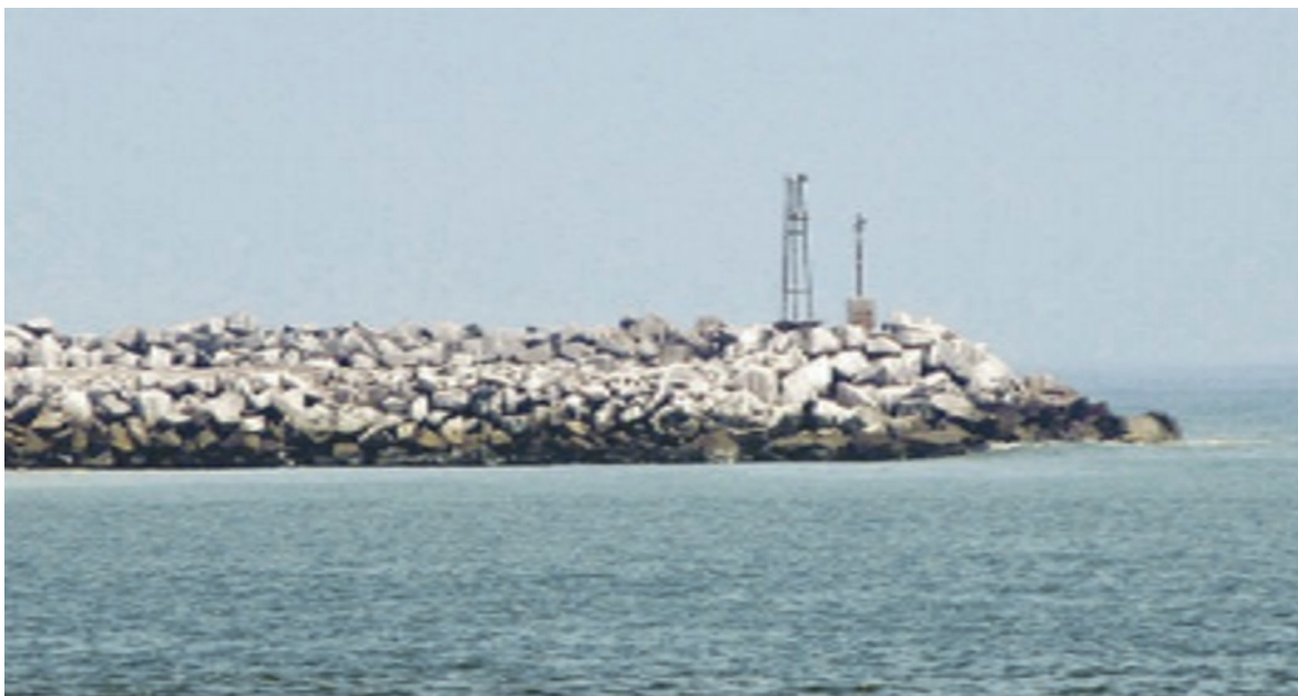
Figura 5. Vista del retenedor de arena rompeolas de Puerto Salaverry
